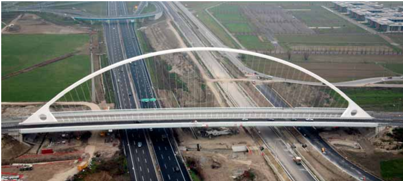
Ponte ad arco
